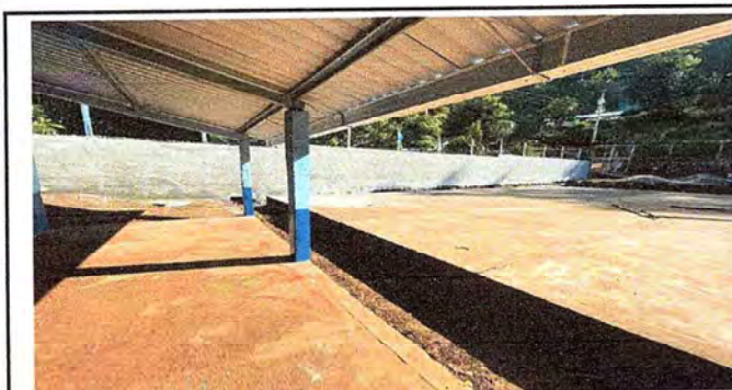
Foto 5: Finalizacion de repello de muro perimetral listo para la ultima fase de pintado
