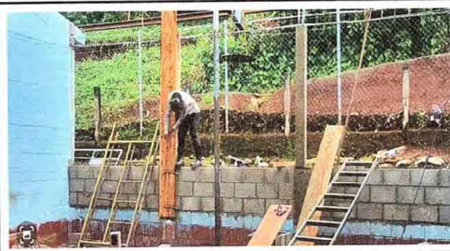
Foto 4: Reparacion de modulos para poder realizar la instalacion de ventanales de vidrio y estructura metalica
