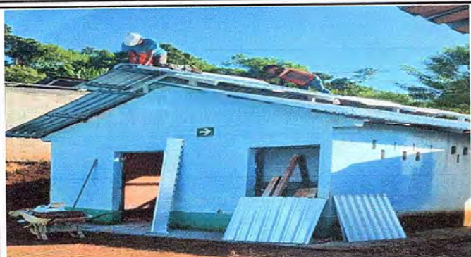
Foto1: Proceso de entechado de estructura metalica al modulo de cocina con los cambios de costaneras y laminas
