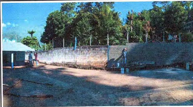
Foto 2: Proceso de repello de muro perimetral
