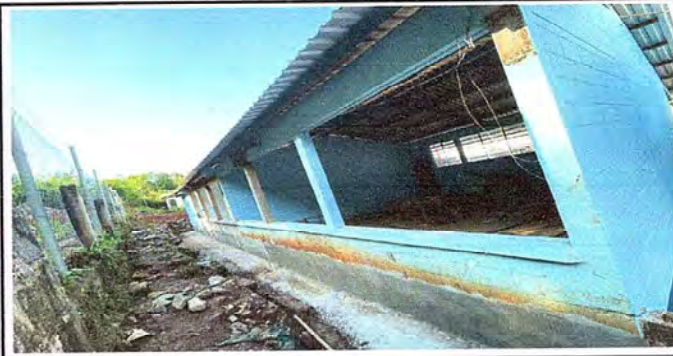
Foto 6: Modulos listos para acabado final de pintado, instalacion de ventanales de vidrio y estructura metalica
