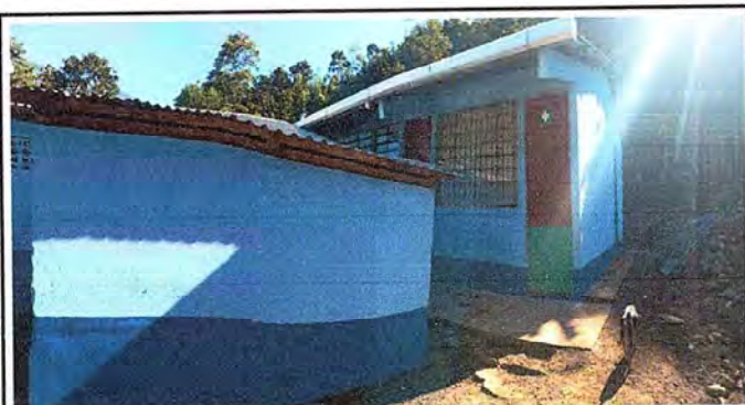
Foto 3: Proceso de cambio de canales de agua de toda la escuela
